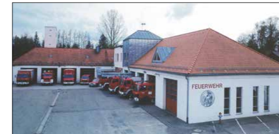
Das Feuerwehr- gerätehaus nach den Umbauten von 1990
