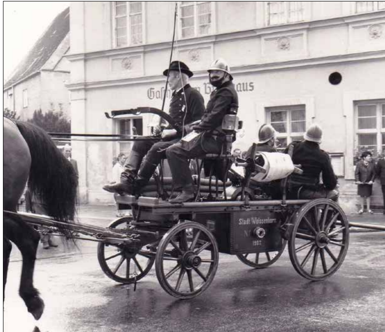
Pferdegezogene „Feuerlöschmaschine“ (Saug- und Druckspritze) der Firma Magirus (1907)
