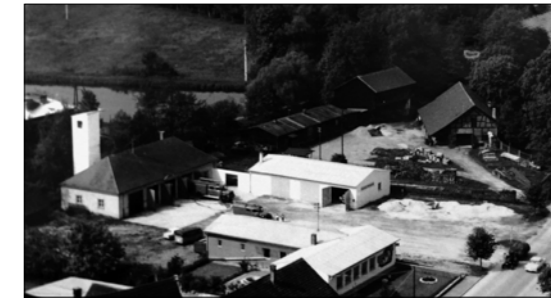
Das Feuerwehr- gerätehaus mit den Erweiterungen von 1960
